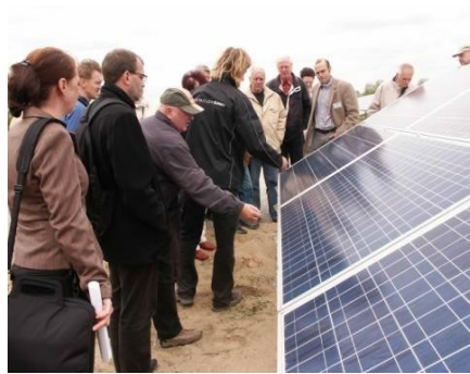
Photovoltaik-Park von IBC Solar (1. Solarexpedition im Rahmen der „Woche der Sonne “)
