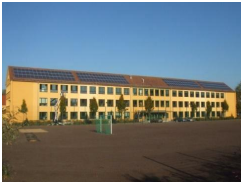
Bürgersolaranlage auf der Integrierten Gesamtschule
