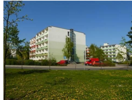
Fernwärmebeheizte Kleinwohnungen in Kiefernheide
