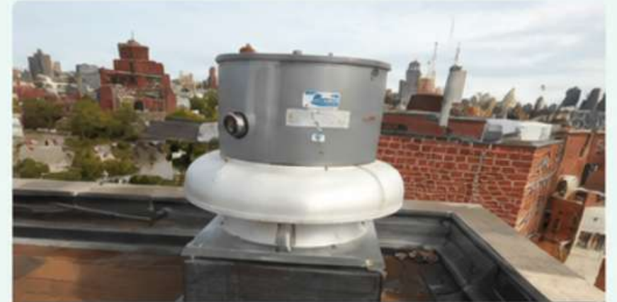
Fan Installation (Before)
